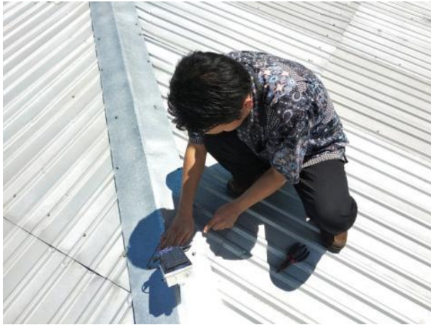
Gambar 9 Proses pemasangan sistem pada atap Universitas Muhammadiyah Gorontalo
